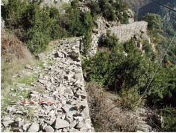
FIGURA 17.—Aspecto del camino del Puerto del Palo en el único sitio que presenta alguna estructura constructiva de interés. Se trata de un muro de contención de mala factura que sostiene un camino de dos metros de ancho. Cuellos de Lenito en el Valle de Echo (cortesía del autor).
